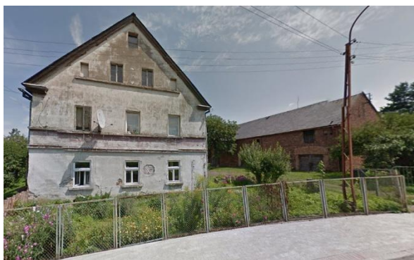
Budynek na ul. Żołnierskiej
