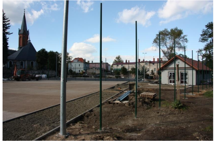
Budowa Orlika w Miłkowie
