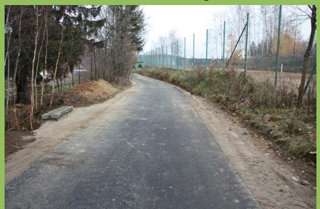
Remont drogi w Zachełmiu
